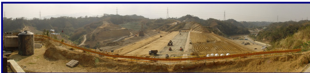
圖 10 2004 年 1 月份寶山第二水庫新建工程現場照片
