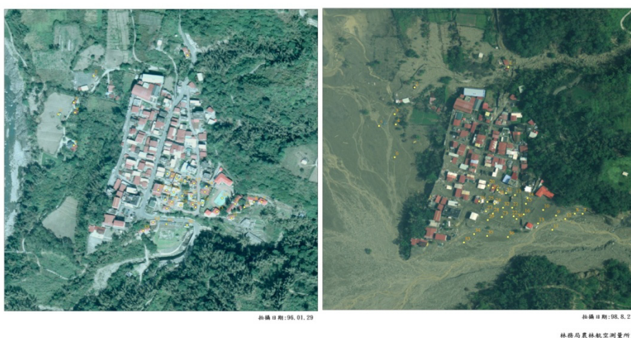
圖 24 高雄縣那瑪夏鄉民族村災前災後房屋毀損點位影像比對圖
