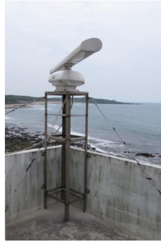
圖 2 本研究於富貴角海岸之雷達架設完成圖
